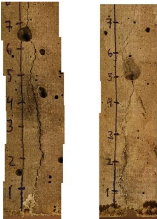
Fig 4: Exempel på spricka efter 1 års nedsänkning i havsvatten. Samma prov som i Figur 2. Vänstra bilden, sprickvidd 0,4 mm. Högra bilden, Sprickvidd 0,2 mm.
